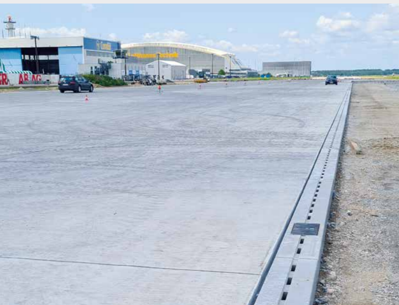
Speziell für den Frankfurter Flughafen entwickelten die Ingenieure des Betonwerks Rinninger eine Schlitzrinne mit besonderen Eigenschaften.
