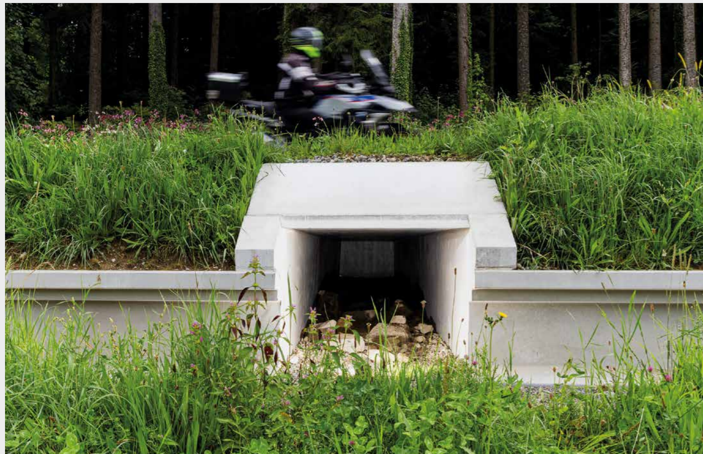
Die Durchlässe wurden aus Hochleistungs- beton C60/75 mit integriertem Fundament ausgeführt.
