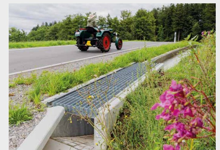
Weil der Einbau in einem kurvigen und sehr bewegten Gelände mit stark wechselnden Quer- und Längsneigungen erfolgte, wurde die Amphibien- schutzanlage sehr flächensparend und straßennah eingebaut.
