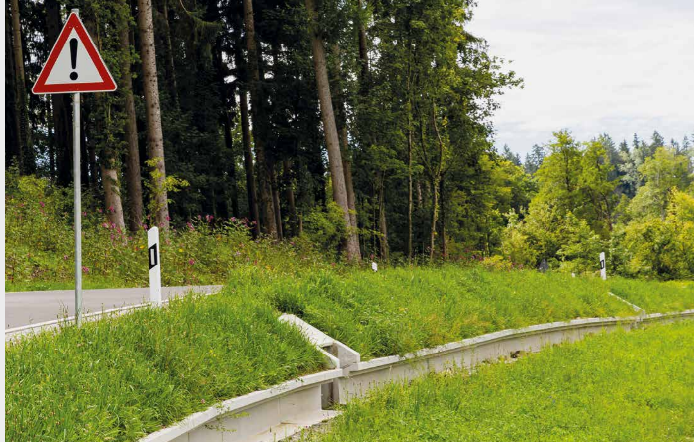
13 Durchlässe unter der K8011 sorgen für eine sichere Querung der Amphibien.
