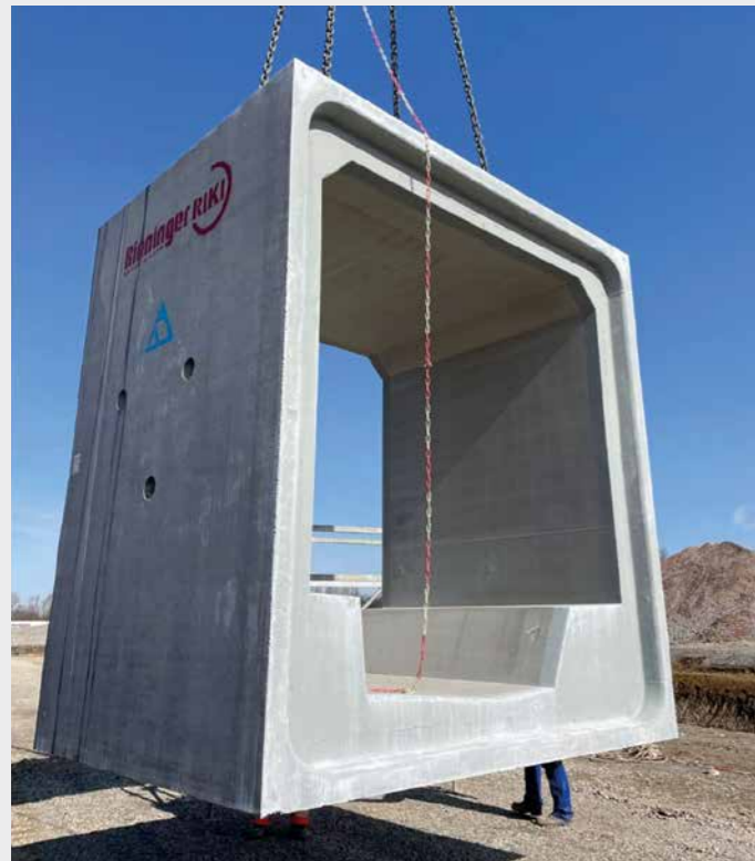
Logistische Meisterleistung: Die Bauteile wiegen gut 27 t.
