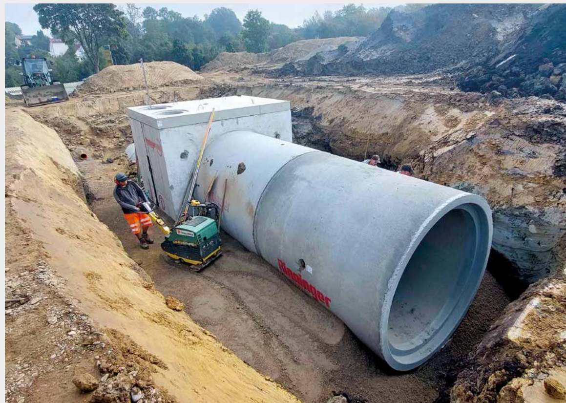
Der Stauraumkanal in Form eines Kreisprofils DN 2200 setzt sich aus zahlreichen Stahlbetonrohren und drei Sonderbauwerken zusammen. Der Rückhalteraum beträgt ca. 340 m³.
