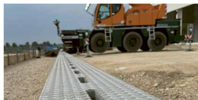
1.000 m | Bereich Halle 22 + 24 • RIKI-CETON® SR 20 mit vollflächiger Edelstahlauflage für extreme mechanische Belastungen
