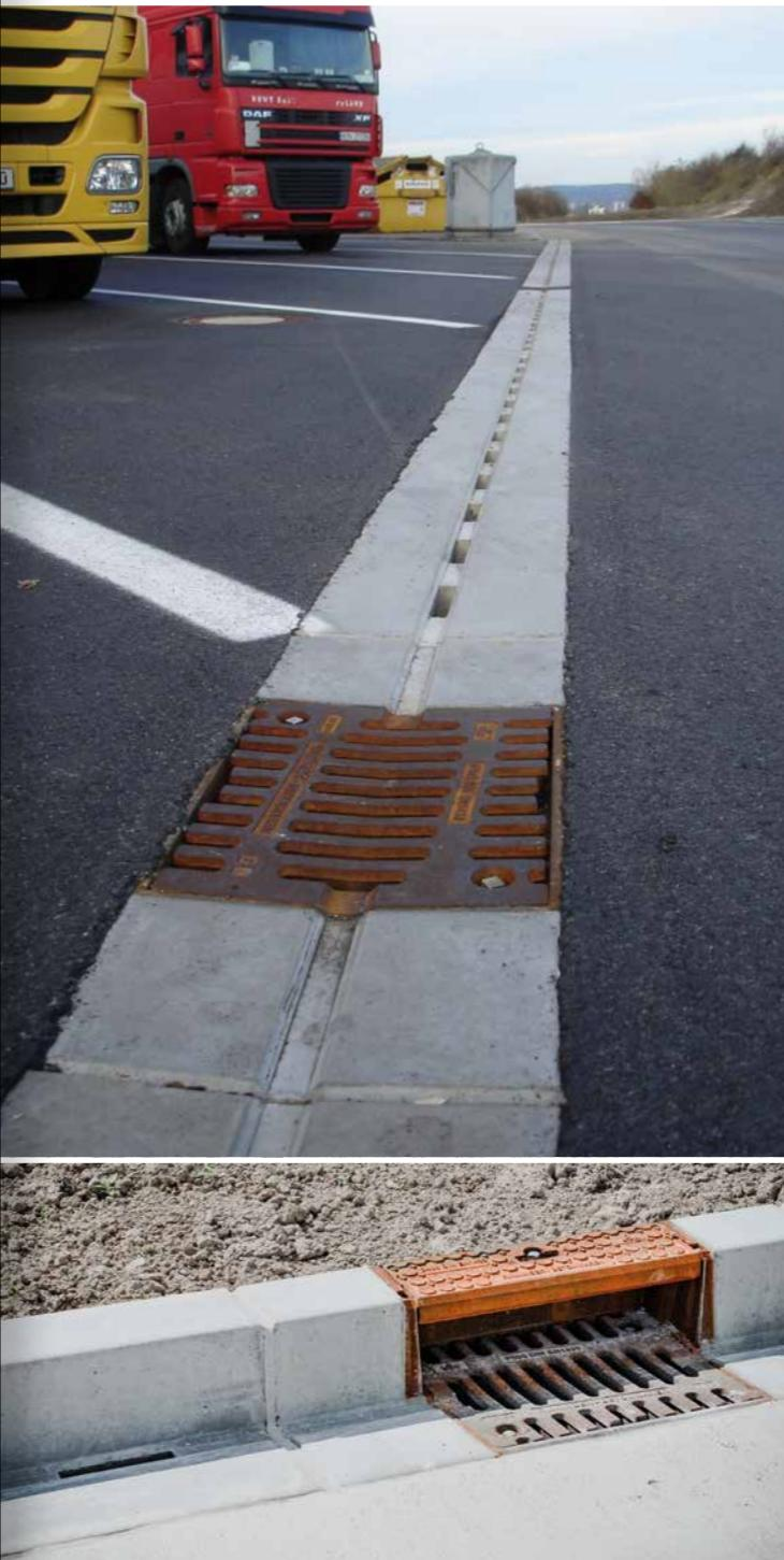
RIKI-Schlitzrinnen ermöglichen auf Großflächen für Fußgänger und Fahrzeuge eine zuverlässige Entwässerung. In diesen Bereichen bieten die Schlitzrinnen mit monolithisch angeformten Bordsteinen nicht nur einen hohen Grad an Sicherheit, sondern auch technisch und optisch eine ausgereifte Gesamtlösung.
