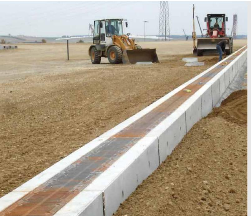
RIKI-Schlitzrinnen erfüllen zum einen die Anforderungen an Extrembelastungen wie sie z. B. durch Industriestapler verursacht werden. Mit der erteilten bauaufsichtlichen Zulassung für LAU-Anlagen bieten sie darüber hinaus einen optimalen Grundwasserschutz bei der Ableitung von wassergefährdenden Stoffen wie Säuren, Laugen, Öle oder Kraftstoffe.
