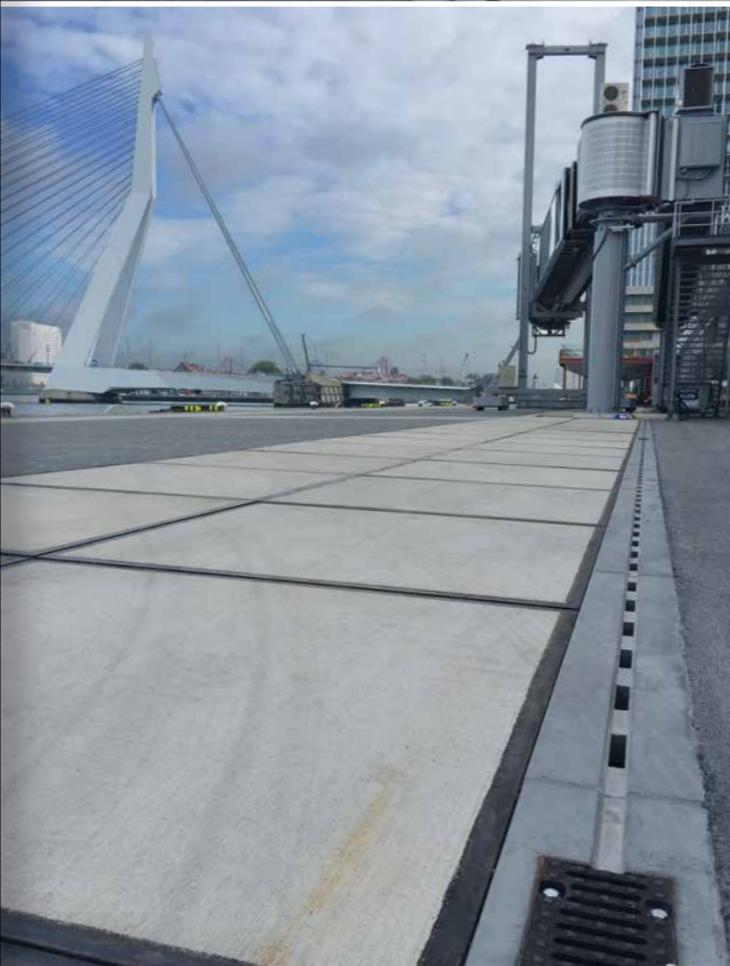
RIKI-Schlitzrinnen bieten ein hohes Maß an Sicherheit beim Einbau in Verkehrsflächen mit extrem hohen Belastungen. Sonderlösungen für Extremstapler, wie z. B. von Reach-Stackern, garantieren so eine zuverlässige und dauerhafte Entwässerung.
