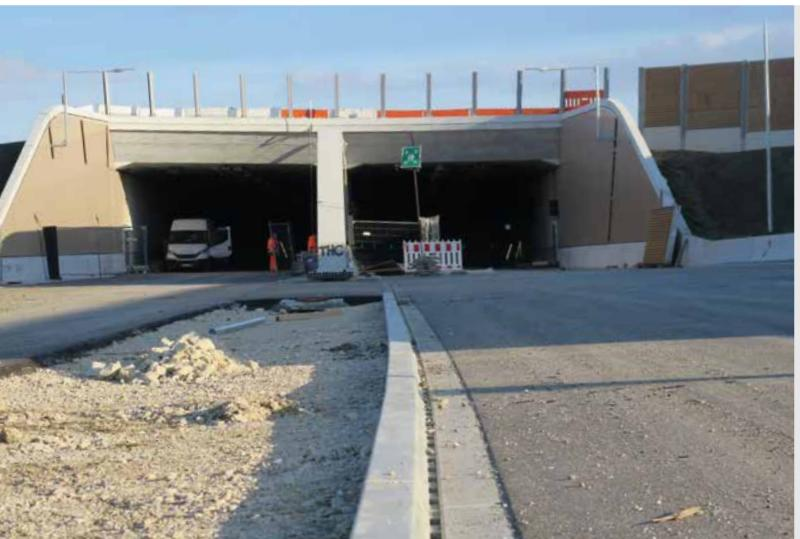
RIKI-Schlitzrinnen leisten in Tunnels wichtige Dienste. Gefährliche Stoffe oder brennbare Flüssigkeiten werden in Verbindung mit speziellen Tauchwandschächten sicher abgeleitet.
