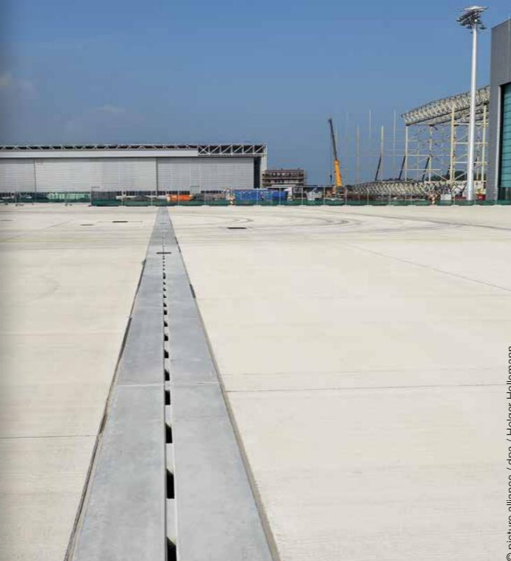
RIKI-Schlitzrinnen erfüllen alle Entwässerungskriterien gemäß dem Merkblatt zur Entwässerung von Flughäfen. In den Bereichen von Enteisungsflächen oder Betankungsanlagen sorgen diese Entwässerungssysteme für LAU-Anlagen für eine vorschriftsmäßige Ableitung von Gefahrstoffen.
