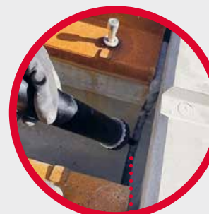
Einbringen einer dauer- elastischen Verfugung
